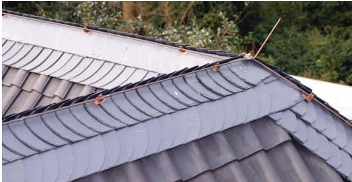
Bestandteile der Äusseren Blitzschutzanlage: Fangleitung und Fangspitze
